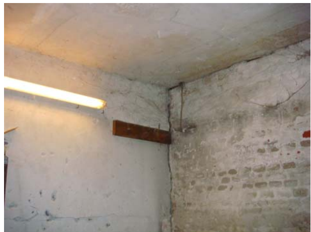
Foto nr. 84 og 85. Foto af skade på loft i garage (tv) samt foto af skade på ikke bærende væg i garage (th).
