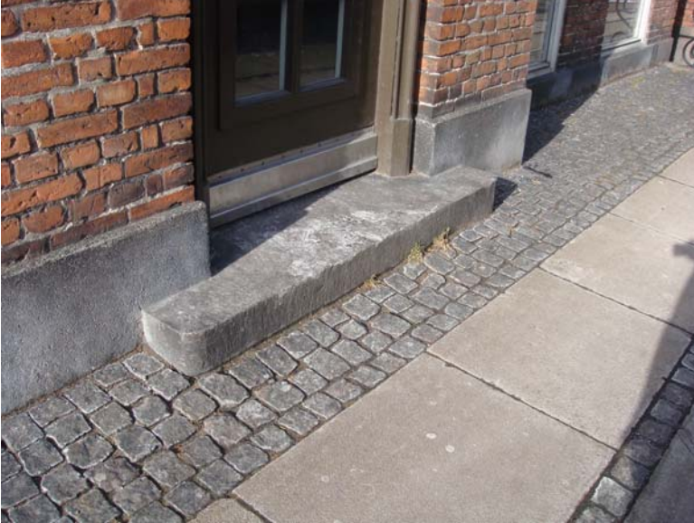
Foto nr. 15. Typisk granittrappetrin ved hovedtrappe.
