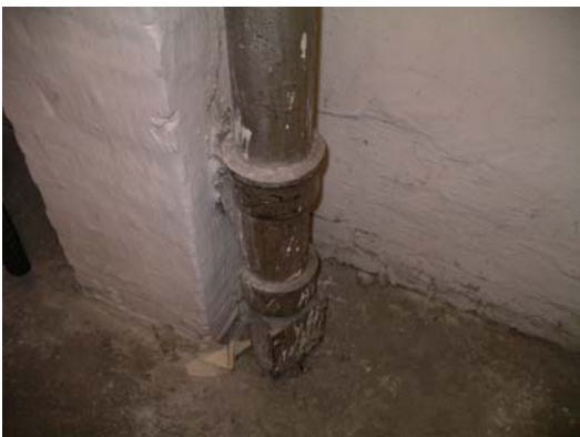
Foto nr. 49 og 50. Eksisterende faldstamme i kælder (tv). Ny faldstamme med rottespærre (th).
