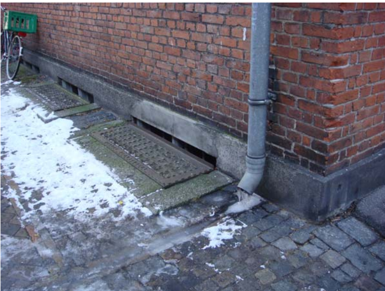
Foto nr. 16. Typisk taggednøb mod gade. Afløb ledes til Kinnekulla-rende.
