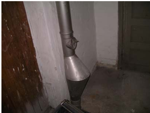
Foto nr. 49 og 50. Eksisterende faldstamme i kælder (tv). Ny faldstamme med rottespærre (th).
