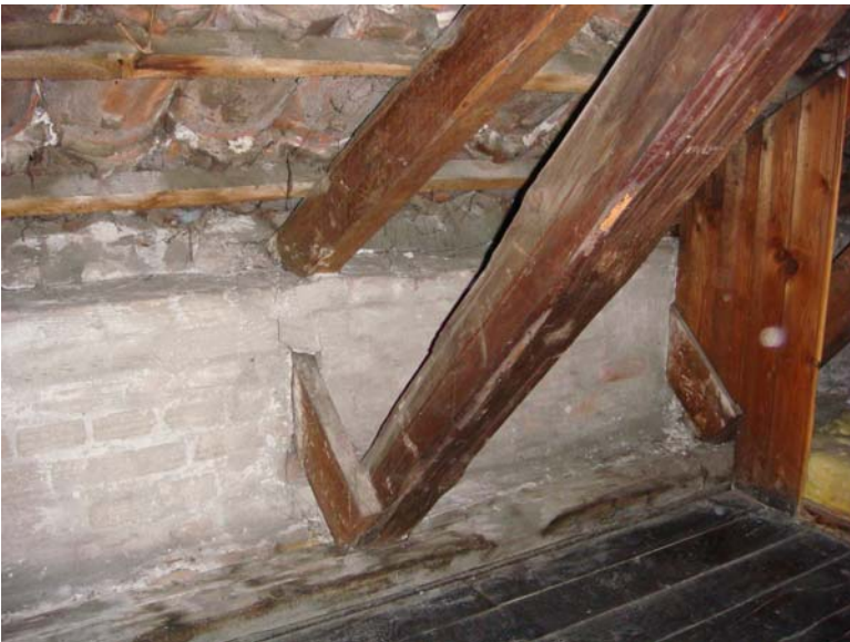
Foto nr. 20. Indvendig tagbeklædning ved tagfod. Tagflade hævet ved de 8-9 nederste rækker tagsten.
