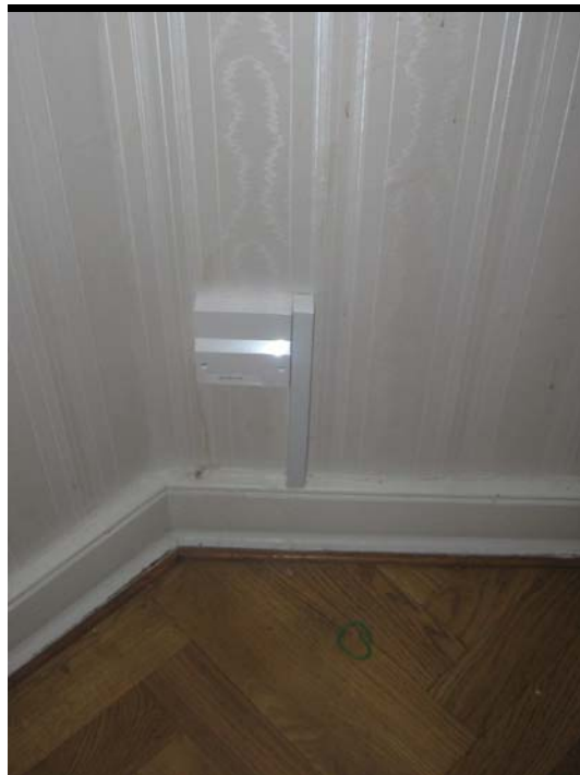
Foto nr. 54+55. Typisk antenne- og bolignetudtag i boligerne.
