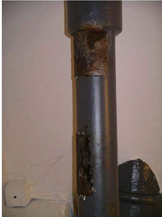
Foto nr. 47 og 48. Gennemtæringer på faldstammer i tagrum og i bolig, Classensgade 52, 1. tv.
