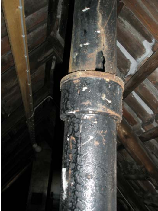
Foto nr. 47 og 48. Gennemtæringer på faldstammer i tagrum og i bolig, Classensgade 52, 1. tv.
