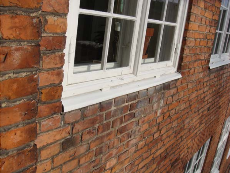
Foto nr. 23. Typisk vindue mod gård.
