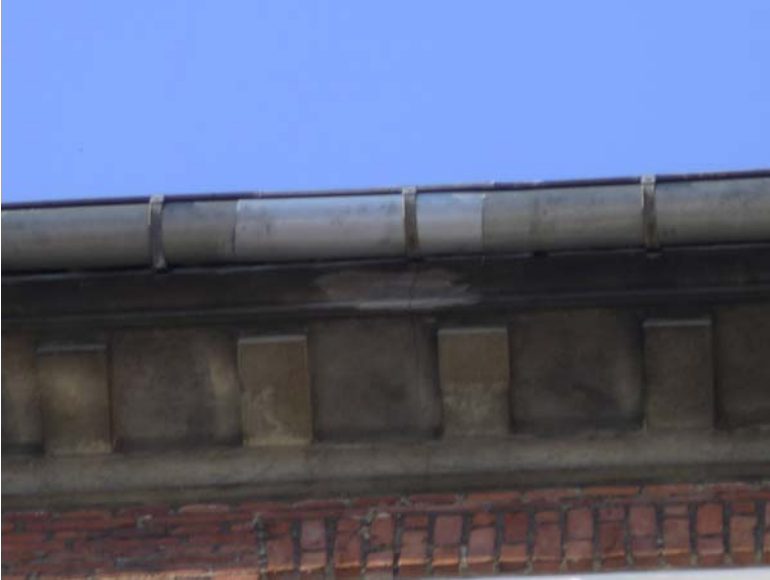
Foto nr. 21. Gesimsbånd og zinktagrende med nyere ekspansionsstykke.
