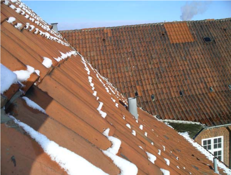
Foto nr. 17. Udvendig tagbeklædning. Der er ses flere reparationer og udskiftede sten.
