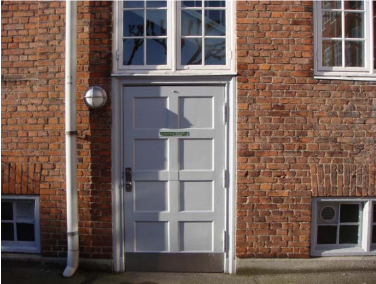
Foto nr. 27. Typisk dør til bitrappe.
