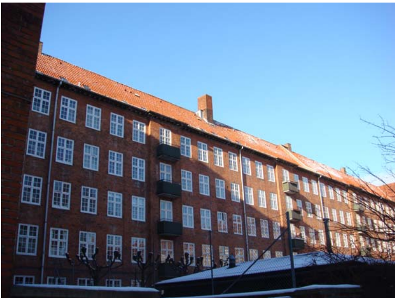
Foto nr. 8. Typisk gårdfacade.
