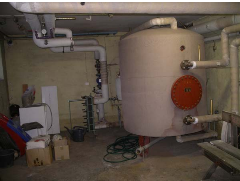
Foto nr. 34. Undercentral, afsnit 5. Veksler er uisolereet og beholder er ude af drift.
