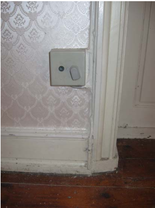
Foto nr. 54+55. Typisk antenne- og bolignetudtag i boligerne.
