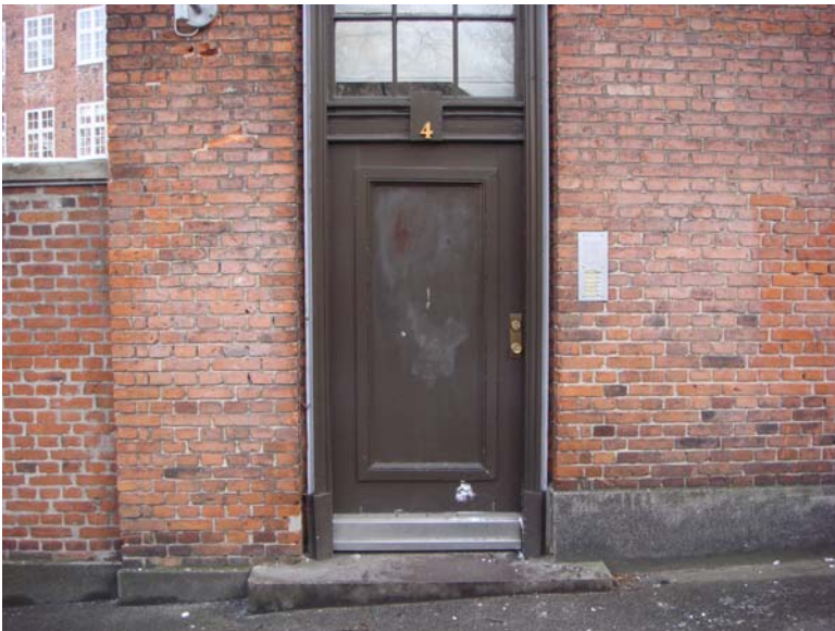
Foto nr. 28. Typisk dør til hovedtrappe.
