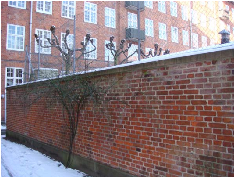
Foto nr. 75. Støttemur i gård mod haveanlæg.
