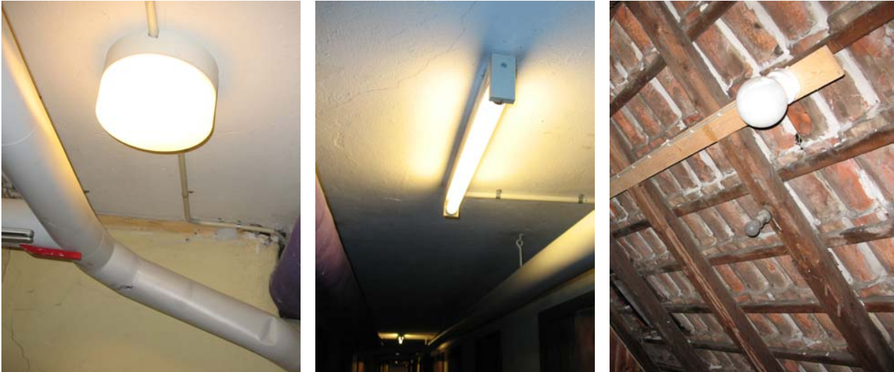
Foto nr. 66+67+68. Forskellige belysningsarmaturer på lofter og spidsloft.
